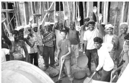
힘든 콘크리트 타설 중에도 환하게 웃는 김재령(가운데)과 공사장 식구들
