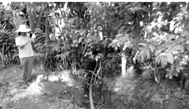
사진 / 다물록 상수도 공사 점검 중인 송지홍 활동가
