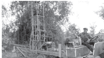
펌프 설치 작업
