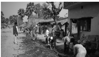
자그디스푸르 마을의 배수로 수리단
