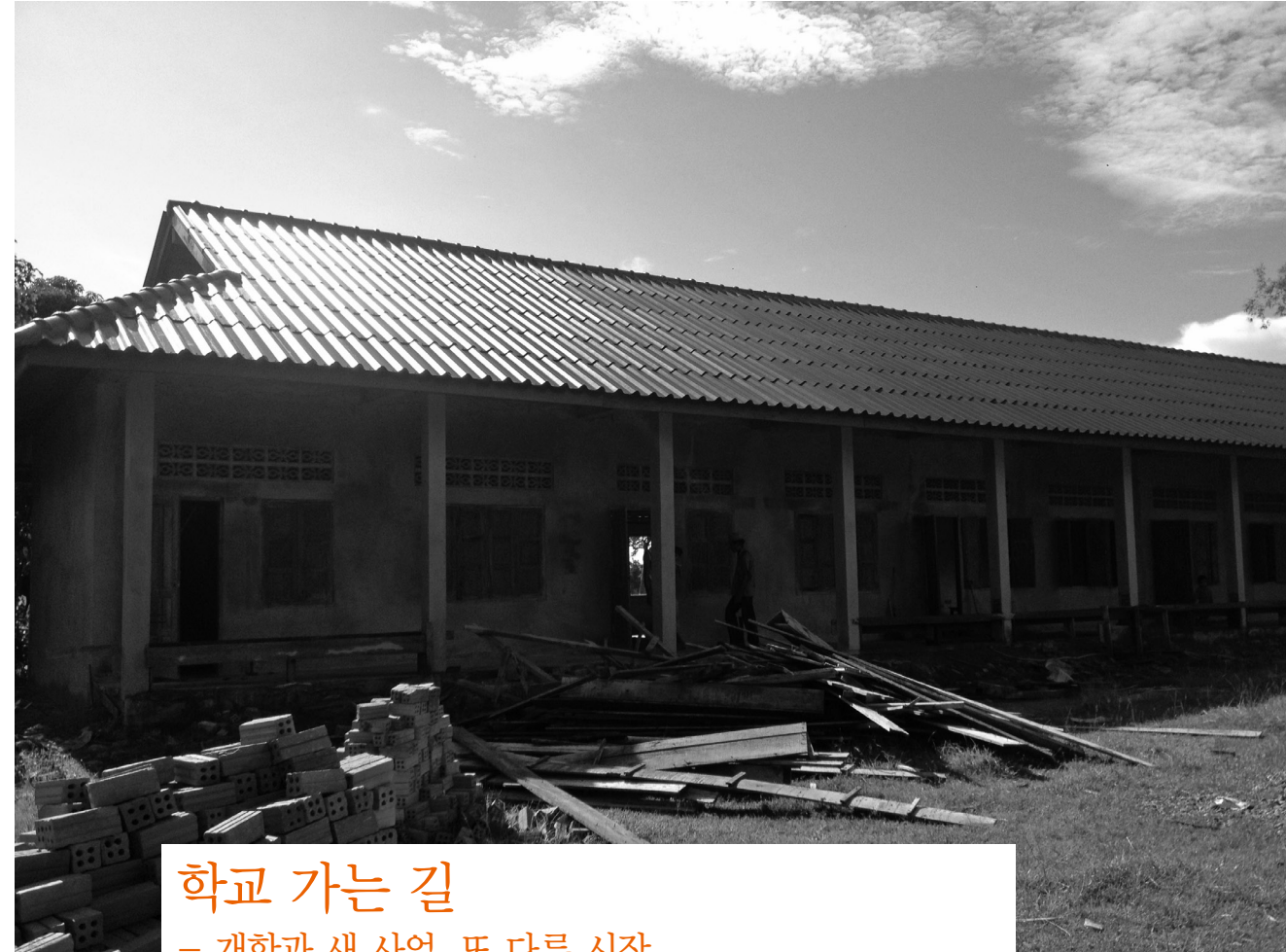
마무리 공사 중인 학교 전경
