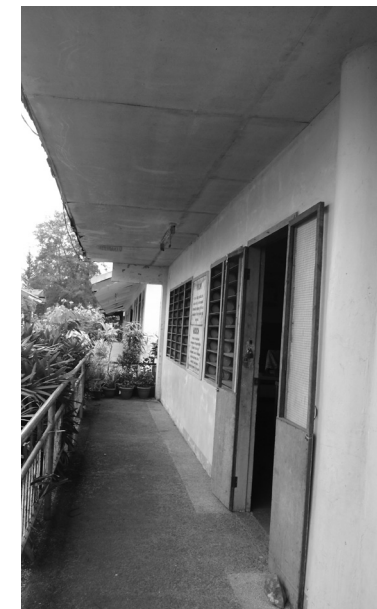
보수 전 교실 복도 모습
