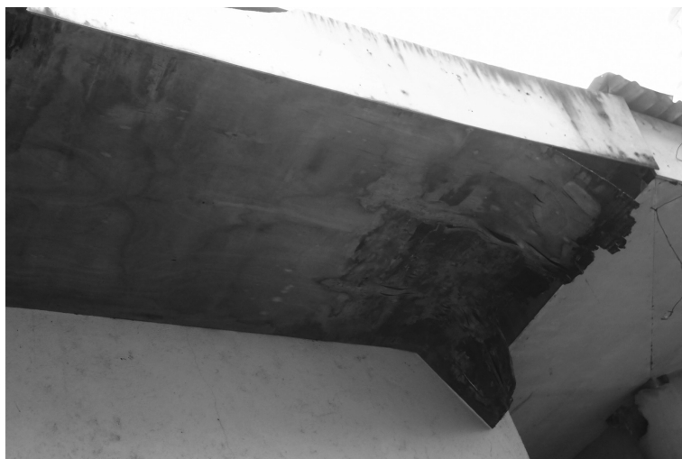
보수 전 교실 내부 천장 모습
