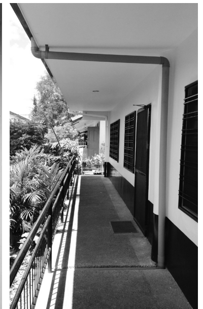
보수 후 교실 복도 모습
